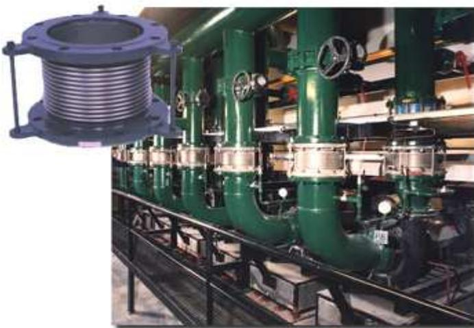
En los casos que el perfecto anclaje no esté asegurado, es conveniente incorporar en los amortiguadores unos dispositivos llamados "tensores" que absorben la fuerza axial evitando que ésta se transmita a la cañería y a los puntos fijos. En este caso la vibración axial no será absorbida, solamente la radial.
